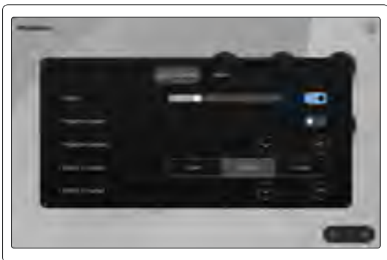
室内制御パネルの例
